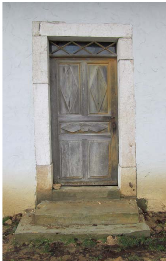
Porte d'entrée côté vallée.
